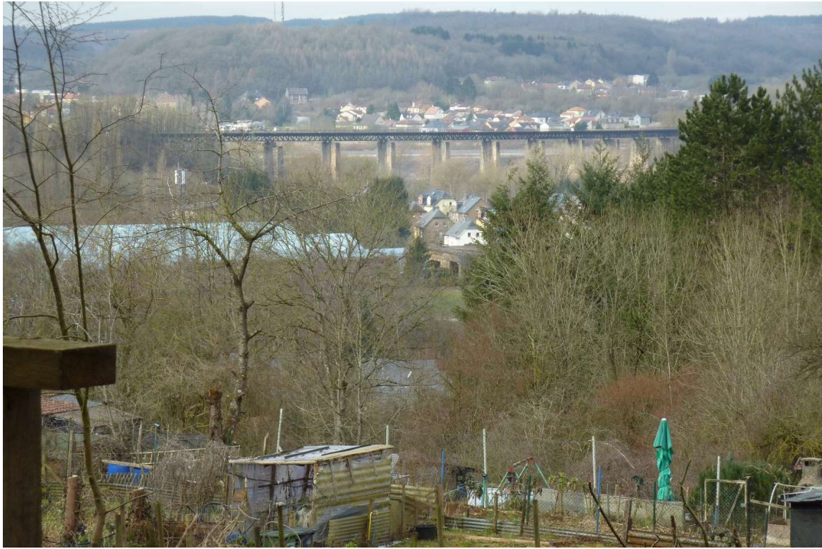
Ancien viaduct ferroviaire d'Audun-le-Tiche
